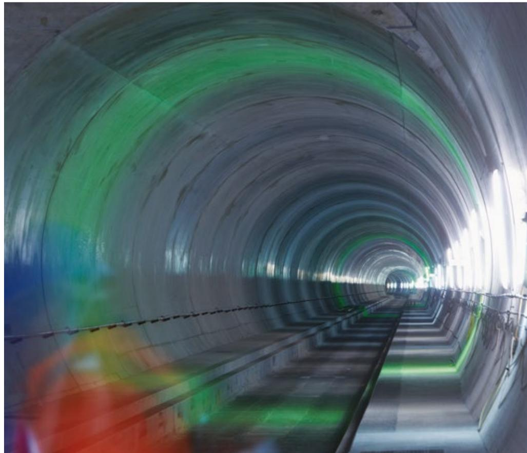
Für den Einbau des Gleises vorbereitete GBT-Weströhre Richtung Nord.
