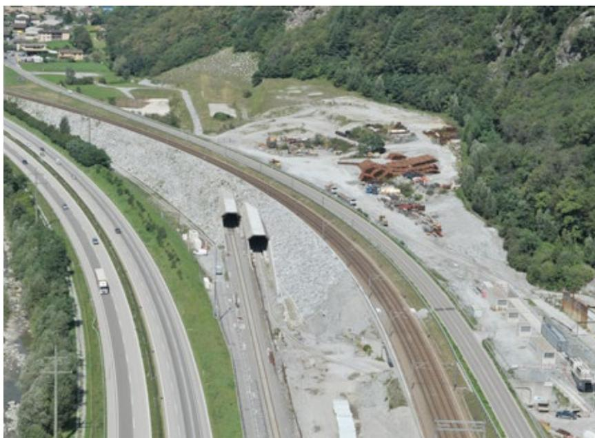
Wird aufgrund von Setzungen regelmässigen Kontrollen unterzogen: Portalbereich Bodio.
